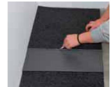
На плитку, перевернутую в предыдущем шаге, наносится разметочная линия в соответствии с необходимым размером.
