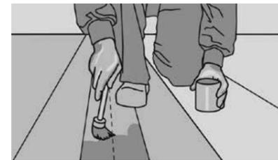
Рис. 90. Из-за толщины покрытия, острые внешние углы должны быть закруглены. Если нужно, используйте двойной слой клея на внешних углах. Покрытие должно быть прогрето феном с тыльной стороны, когда укладывается на угол. Клей наносится два раза на ширину 150 мм на каждой стороне угла (см. рисунок).
